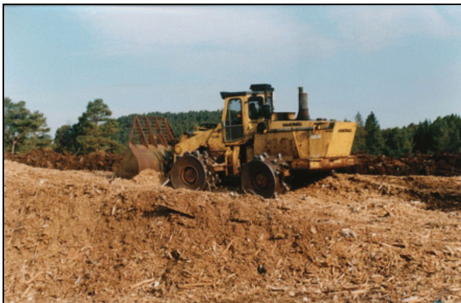
Figur 1. Det er benyttet store mektigheter med oppflist trevirke ved drenering og utjevning av myren i Hordnesmarka.
