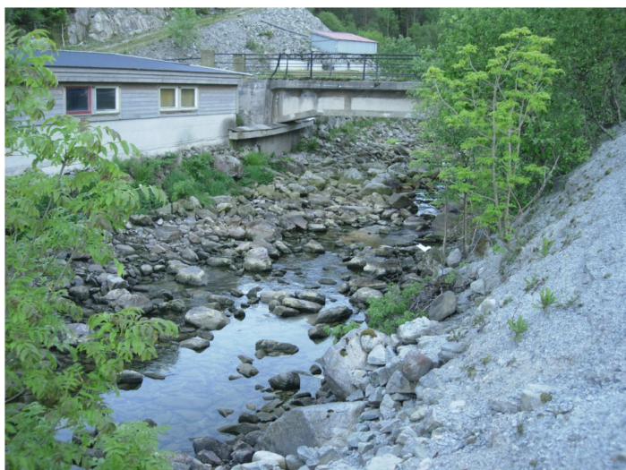
Figur 2.1. Nedre del av Oltesvikbekken i Oltesvik der det ble elektrofisket 26. mai 2008. Karene der det produseres smolt kan skimtes bak broen i øvre billedkant. UTM referanse: LL 340 271
