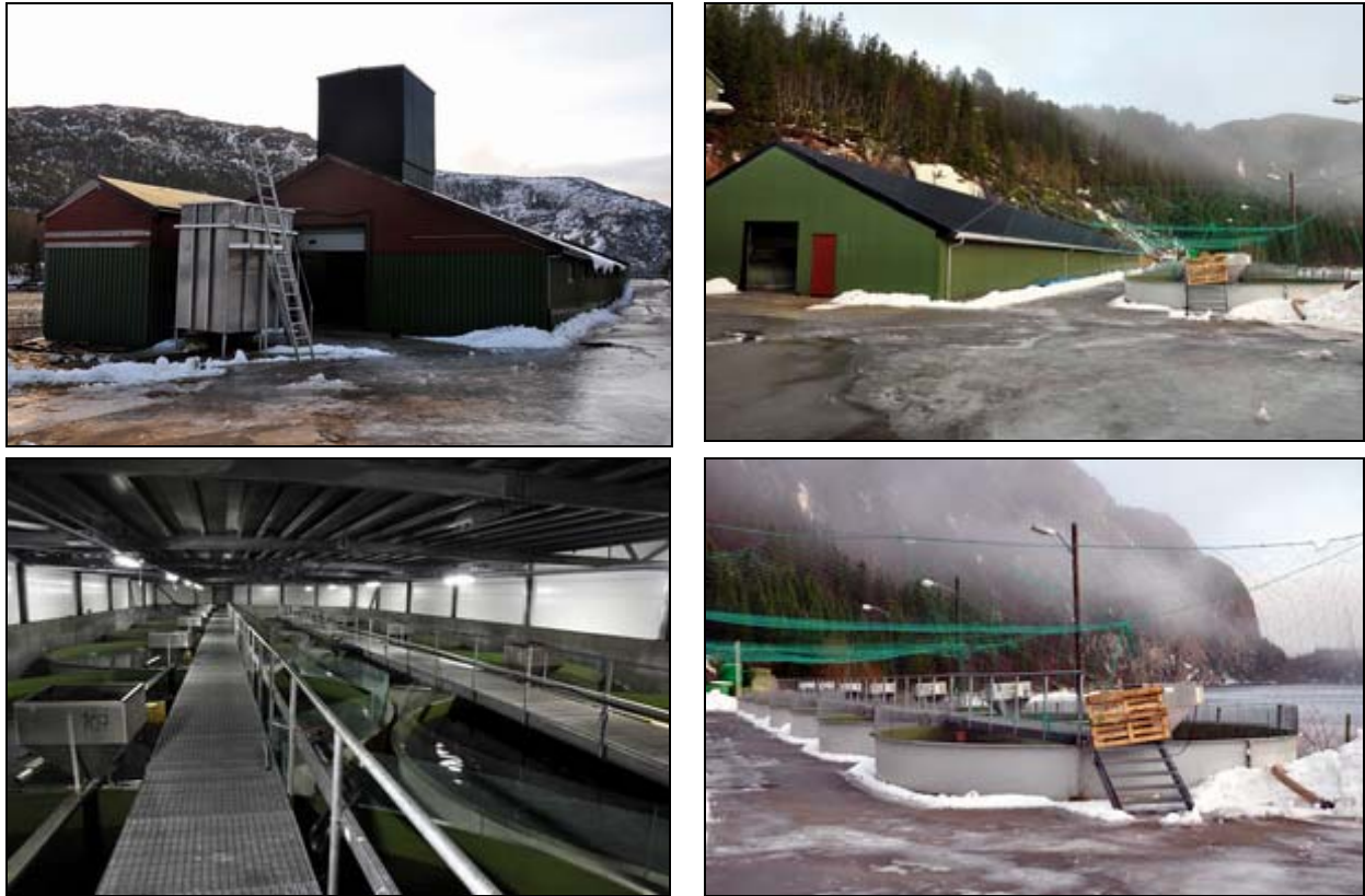
Figur 2. Anlegget består av flere seksjoner. 500 hallen og 600 hallen inneholder henholdsvis 20 og 21 stk 5m kar (øverst til venstre og høyre). 100 hallen inneholder 8 stk 8m kar (oppe til venstre), og ned mot sjøen står det en karrekke ute med 7 stk 8m kar (oppe til høyre).
