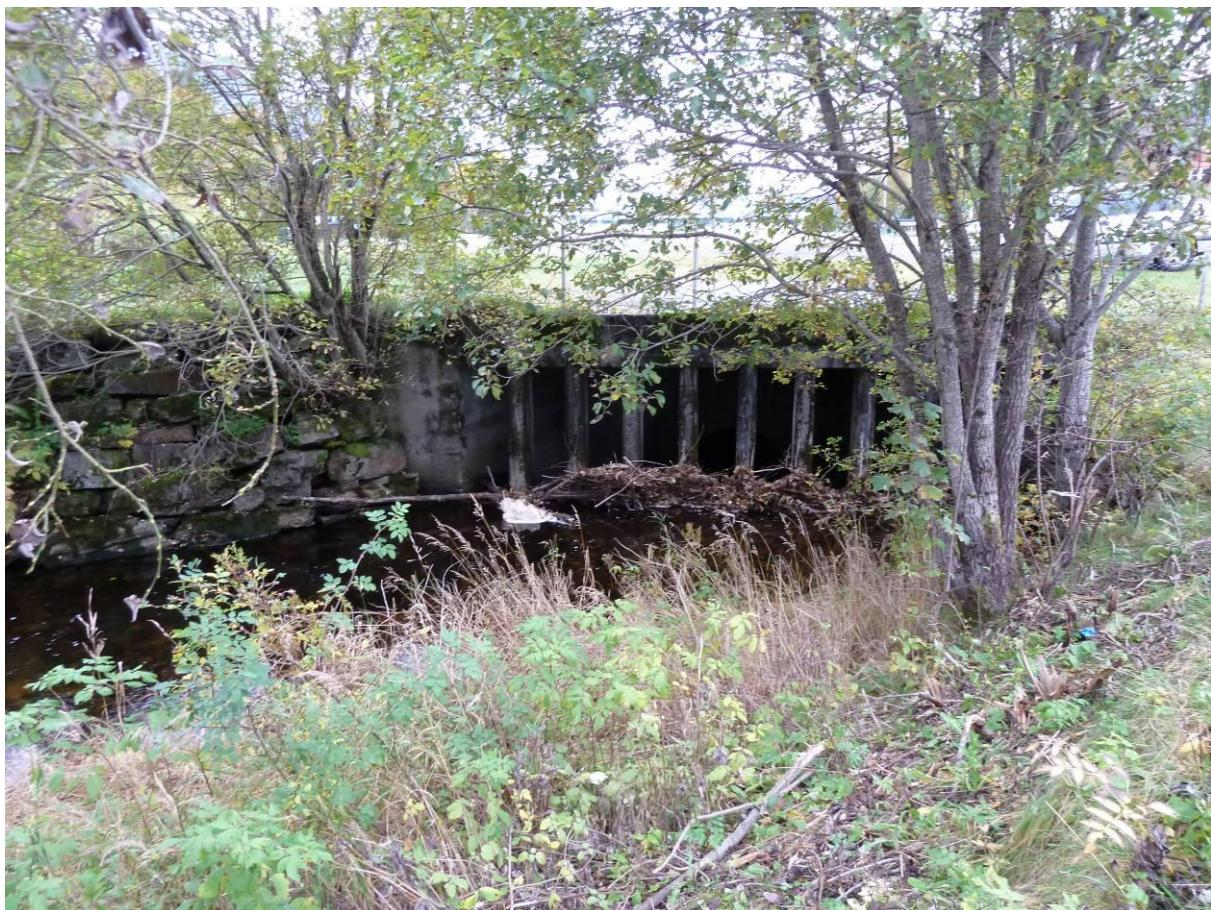
**Figur 7.** Øvre del (inntaket) til kulverten som går under fotballbana er truleg den største hindringa for ålen si vandring opp i vassdraget.
