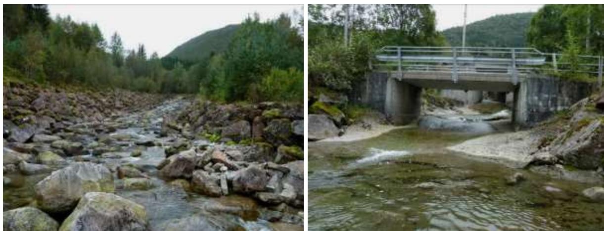
**Figur 20.** Øvre del av anadrom strekning i Vossadalselvi er plastral med blokk. I nedre del er store delar av elvestrengen fylt igjen med betong. Foto: Bjart Are Hellen.
