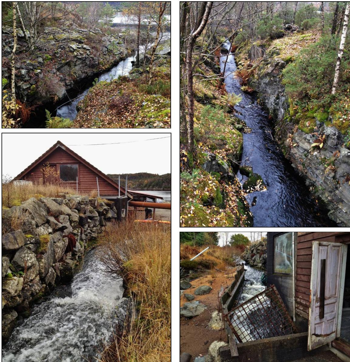
**Figur 3.** Utløpselva frå Steinsvatnet er skote ut som ein 2-3 m djup kanal på dei øvste 100 metrane (**dei to øvste**), og utløpet til Halsvikvågen er også kanalisert med kantar og støypt botn ned mot eit røyr under kai og industriareala ved sjø. Her er elva stengt med ei rist for å samla rusk og rask (**dei to nedste**).
