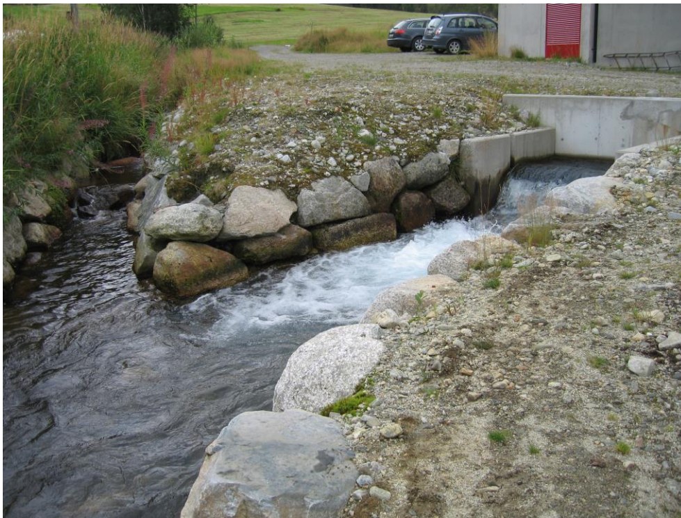
Figur 3. Avløpet frå kraftverket renn ut i gytegrova til venstre.
