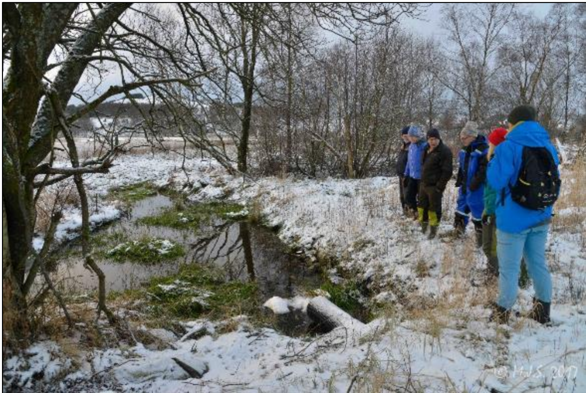
Figur 3. Grunneiere viser ved befaringen utløpet til dreneringsanlegget. Kanalen som fører vannet til tjernet er nesten helt gjengrodd. Foto: Magnus J. Steinsvåg
