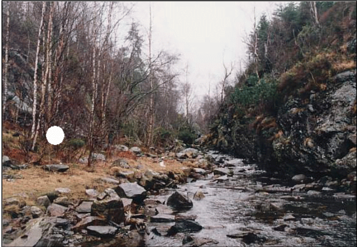
FIGUR 7: Nederste del av Pollelva med planlagt nedre ende av borehullene vist med hvit sirkel til venstre i bildet. Den planlagte grøften er foreløpsått lagt på elvesletten til venstre.
