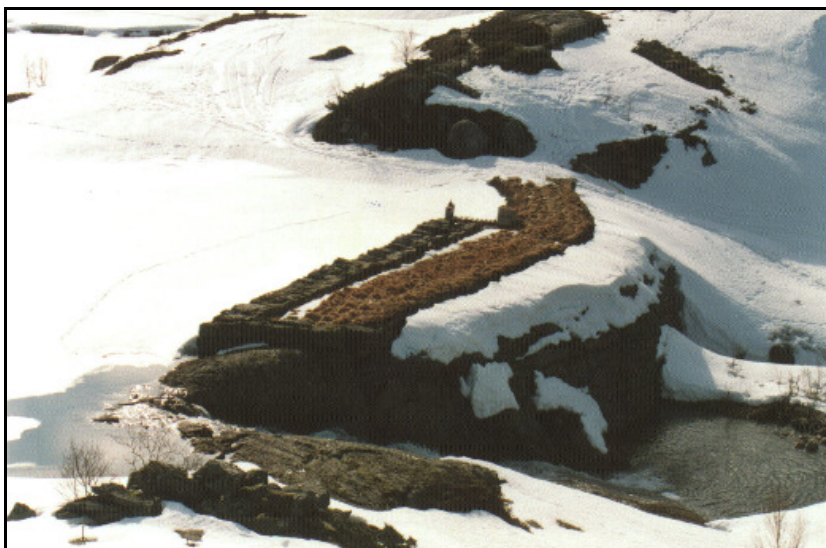
Figur 2. Demningen ved utløpet av Bogevatnet 12.april 2000. Overløpet sees nede til venstre, mens tappeinnretningen ligger til høyre.
