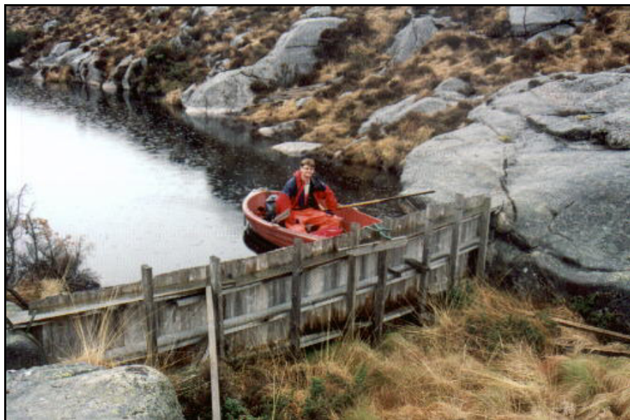
Figur 5. Det tidligere utløpet av Gamlasætervatnet er i dag demmet opp med en enkel trekonstruksjon. Dette er "dam 4" og "overføring 2" på kartet i figur 1 .
