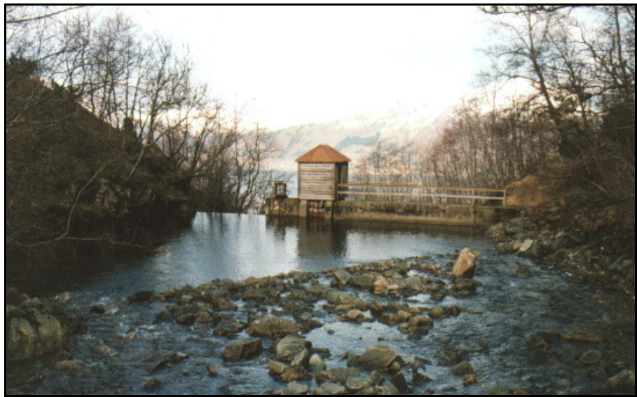
Figur 3. Inntaksdammen for Vaksdal kommunale vassverk og tidligere Boge kraftverk i Bogedalen
