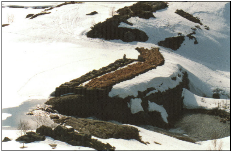
Figur 2. Demningen ved utløpet av Bogevatnet 12.april 2000. Overløpet sees nede til venstre, mens utløp fra tappeinnretningen er ut til høyre.
