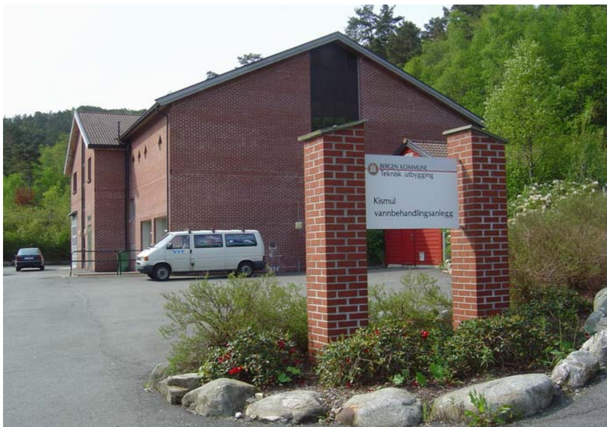
Figur 2. Kismul vannbehandlingsanlegg er et nytt og moderne anlegg, som ble satt i drift i 1996.
