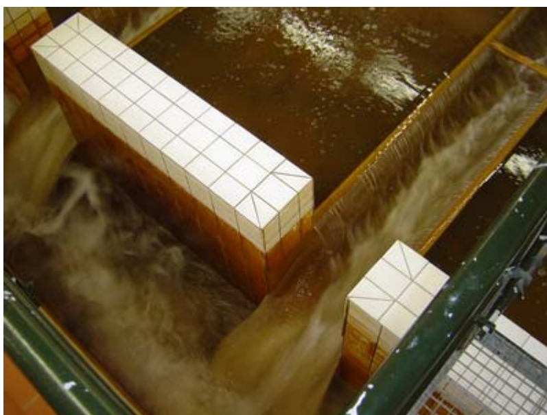
Figur 4. Spyling og rensing av sandfiltrene skjer ved at filteret først bobles med luft slik at det sedimenterte stoffet frigjøres, og så spyles alt slam og vann ut. Slammets renses så fra, og rejektivannet utgjør den resterende vannfasen av dette.
