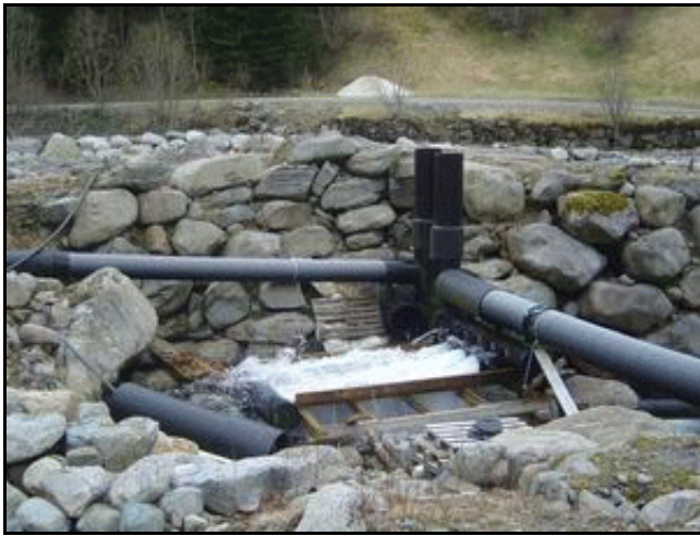
Figur 2. Vanninntaket i Ytre Standalselven (over), med opplegget for mottrykks rensing ved høy vannføring (til venstre).
