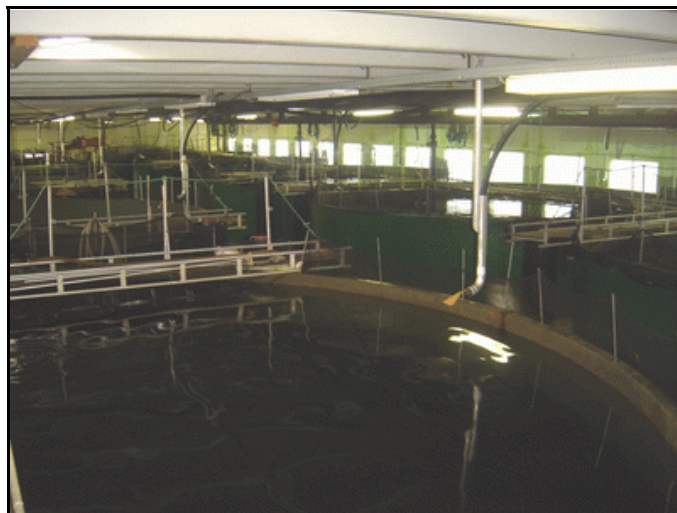
Figur 1. Anlegget disponerer i dag store 10 stk 8-meters kar i en relativt trang driftsbygning, samt en rekke større og mindre karenheter i forbindelse med klekkeri.
