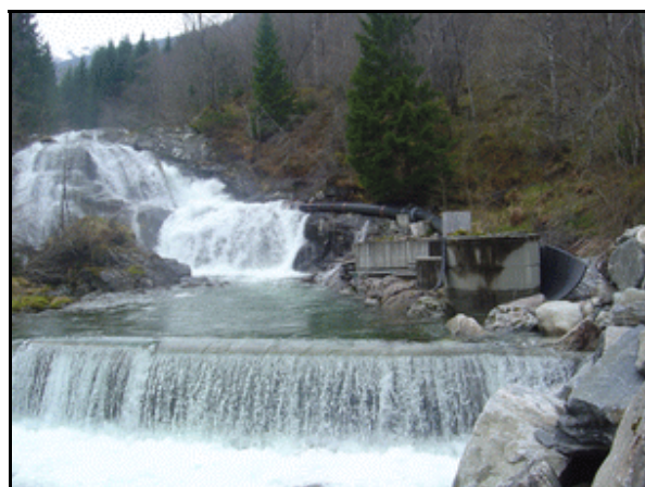
Figur 2. Vanninntaket i Dravlauselven, med terskel (til venstre) og inntakssystem med nødsikring i fossen (til høyre).
